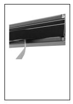
Ebarber à l'aide du cutter la barre acoustique en le rendant de la bonne longueur, c'est-à-dire la mesure intérieure du siège de la plinthe escamotable.
