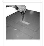
Les tôles intérieure et extérieure du vantail sont pré-percées pour la fixation du judas. C'est possible de choisir entre deux trous situés à H de 150cm et de 145cm (la mesure est à considérer entre l'axe du trou, qui a diamètre de 2,4cm, et le bord inférieur de la tôle – mis à part les cas de portes coupées au-dessous).
