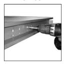
Appliquer le profilé à oméga sur le fond du vantail en ayant soin de le centrer par rapport aux montants. Afin de conserver la position obtenue choisir un des trous qui se trouve en position centrale et y appliquer une vis auto-perçante de 4,2x13 à l'aide du tournevis.
