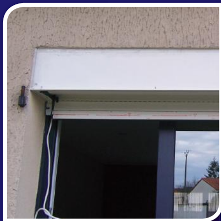
Pendant les travaux
