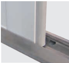
Seuil aluminium avec joint d'étanchéité
