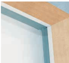
Joint d'étanchéité en périphérie
